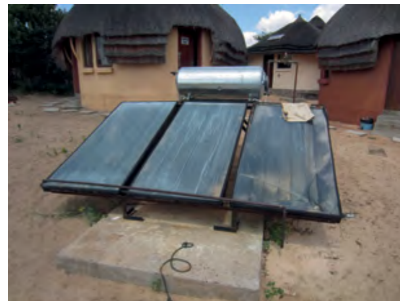
Abb2b: Im südlichen Afrika fehlt vielerorts das Wissen zur Instandhaltung von Anlagen zur Erzeugung regenerativer Energien, wie diese Abbildung eines beschädigten Solarkollektors zeigt.
